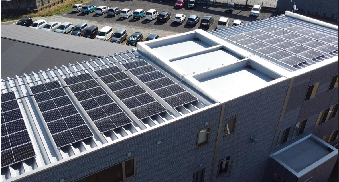
写真：アグロジャパン新潟本社屋上（ドローン撮影）
